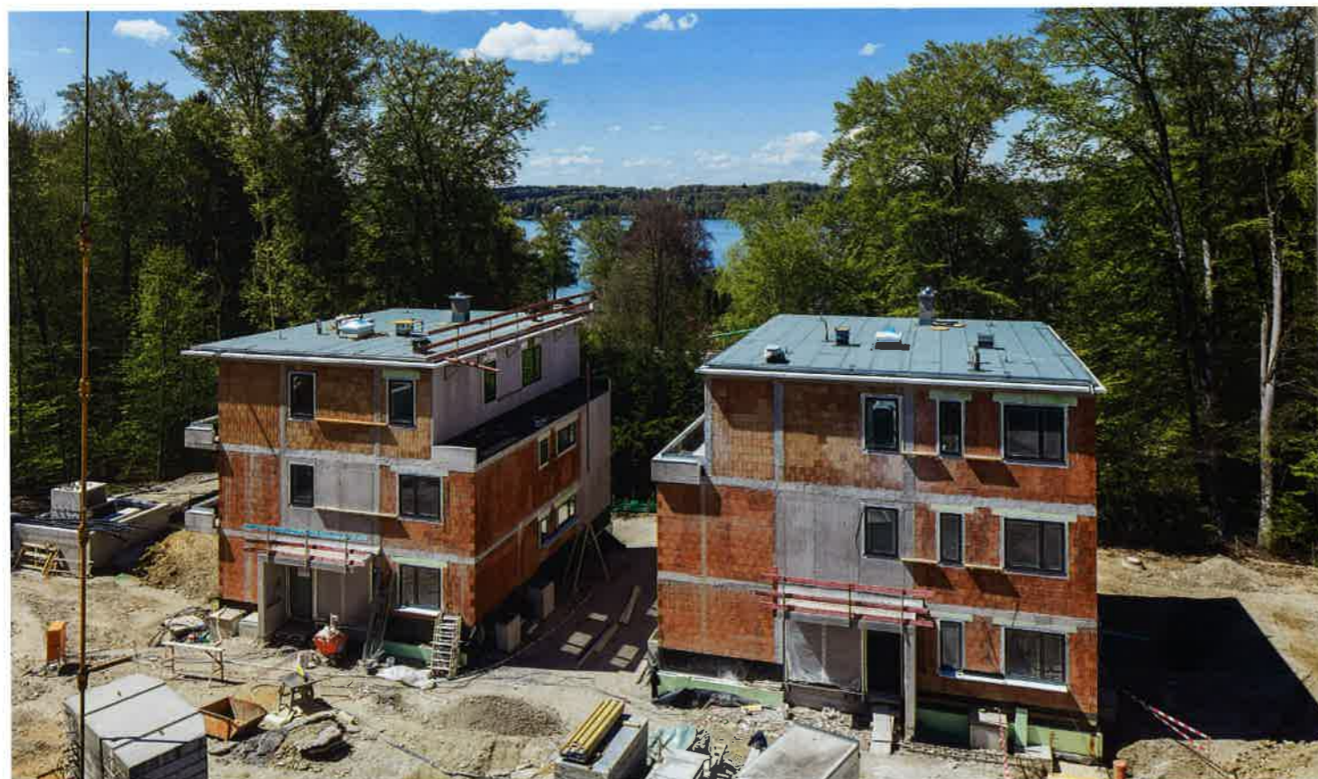
Blick vom Penthouse zum See. Im Vordergrund: Villa 1 und 2 des Villenensembles.
